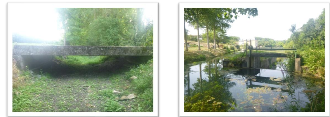
Figure 22 : Ouvrages type rencontrés sur le site d'étude
